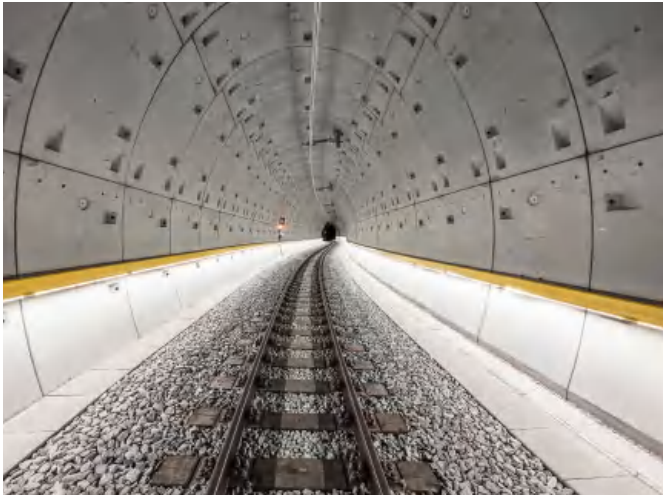
LaneLED GFK, Glatscheras tunnel
